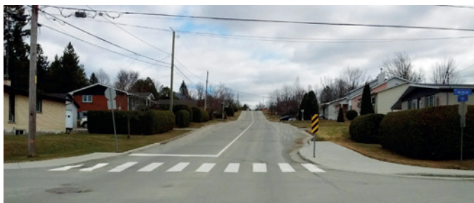
Figure 19 – Saillie non connectée à un réseau de trottoir et passage piéton contrôlé
